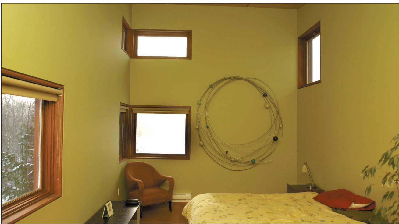
Le positionnement des fenêtres dans la chambre principale favorise la circulation de l'air, du bas vers le haut.
