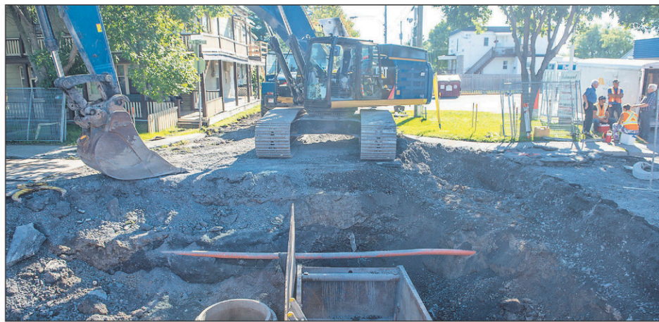
Il reste encore 95 kilomètres de conduites combinées à remplacer sur le territoire de la ville.
