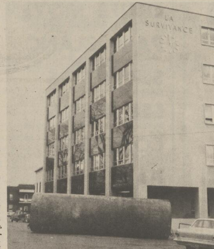
CET ENORME RESERVOIR a été retiré de la lisière de terrain située derrière l'édifice de La Survivance, hier après-midi, à Saint-Hyacinthe. Le cylindre géant a été déposé pendant un certain temps devant l'édifice, sur la rue Girouard, à la surprise des passants, pour être ensuite transporté à bord d'un camion remorque. (Photo Bouchard)
