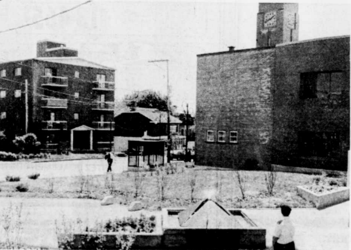
Avant, pendant et après! En moins de 24 heures, l'environnement du nouvel hôtel de ville de Beauport a changé du tout au tout: grâce à la célérité des démolisseurs, la maison historique qui jouxtait l'édifice municipal a fait place à un coquet petit espace vert.
