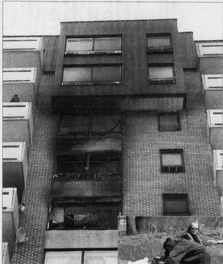
Sur la photo principale, on aperçoit la partie de l'édifice qui a été incendiée avec, en bas, l'appartement du dixième étage de Laura Russell. En médaillon, Laura fouille dans les sacs contenant tout ce qui lui reste pour tenter de retrouver des photos de son fils décédé.
