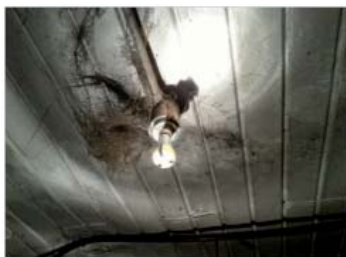
Type de luminaire marin (en PVC) avec ampoule au DEL sans le protecteur de verre
