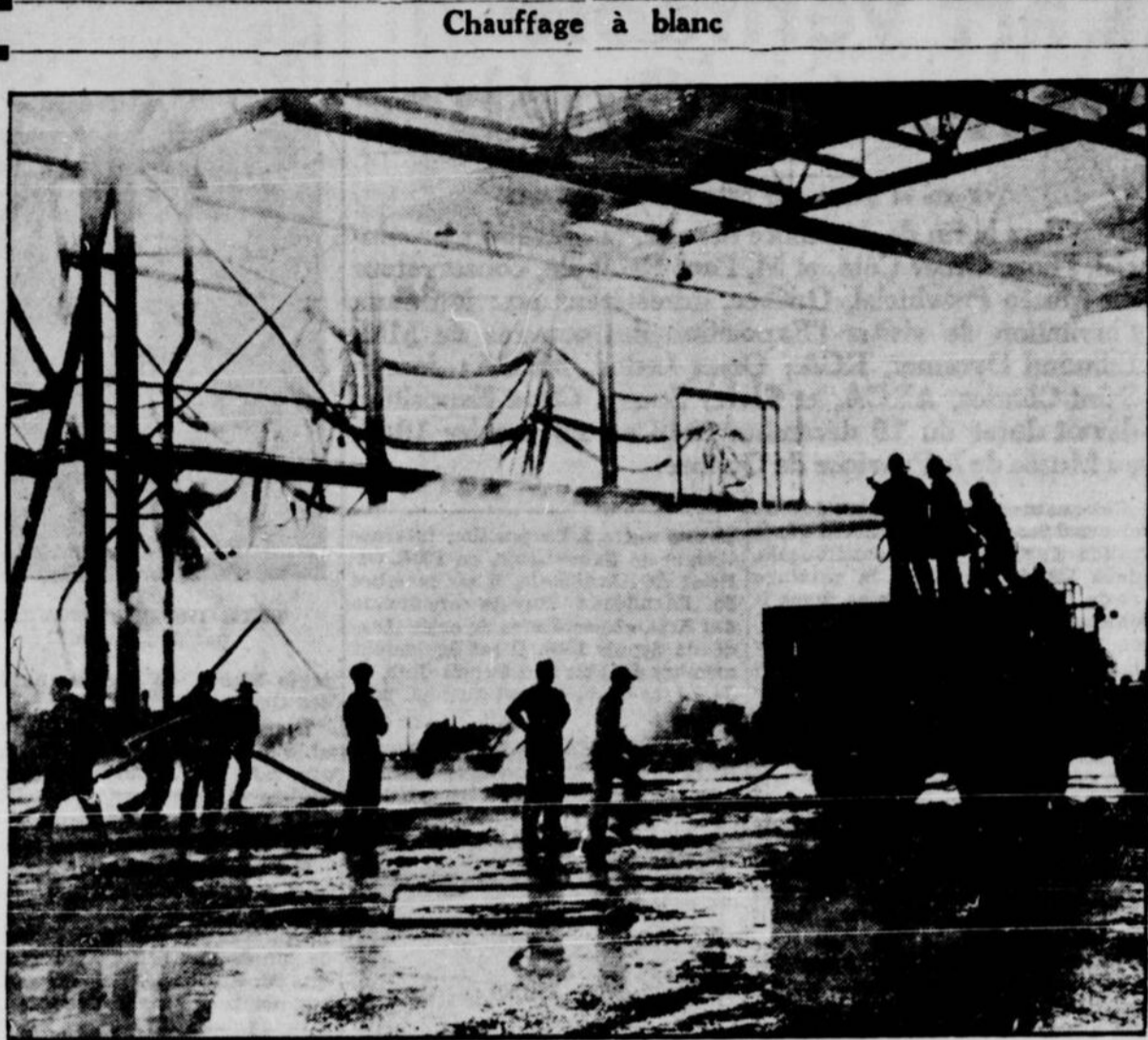
Au moins dix personnes ont trouvé la mort et trente-huit autres ont été blessées au cours de ce spectaculaire incendie qui détruisit de fond en comble cette aérogare de deux étages, la plus grande au monde, au camp d'aviation militaire de Tinker, près d'Oklahoma-City. Plusieurs centaines d'aviateurs eurent la vie sauve en sautant du deuxième étage de la bâtisse. Les hommes transportèrent les femmes dans leurs bras en lieu sûr. Les cadavres des victimes, entièrement calcinés et méconnaissables, furent retrouvés sous les débris d'un mur. Les dommages matériels sont évalués à plus d'un million de dollars.
