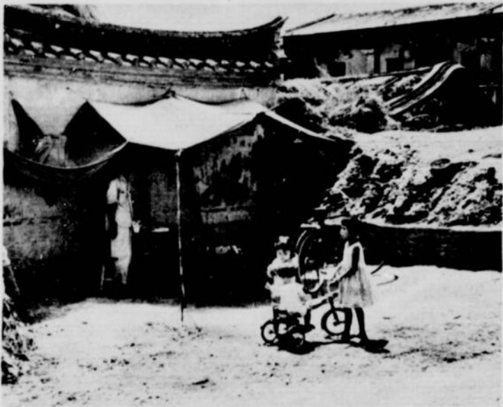
Les enfants ne doivent pas s'éloigner des abris, surtout les jours de bombardement. Ces refuges sont faits de béton. Il en existe 1 par 5 civils.
