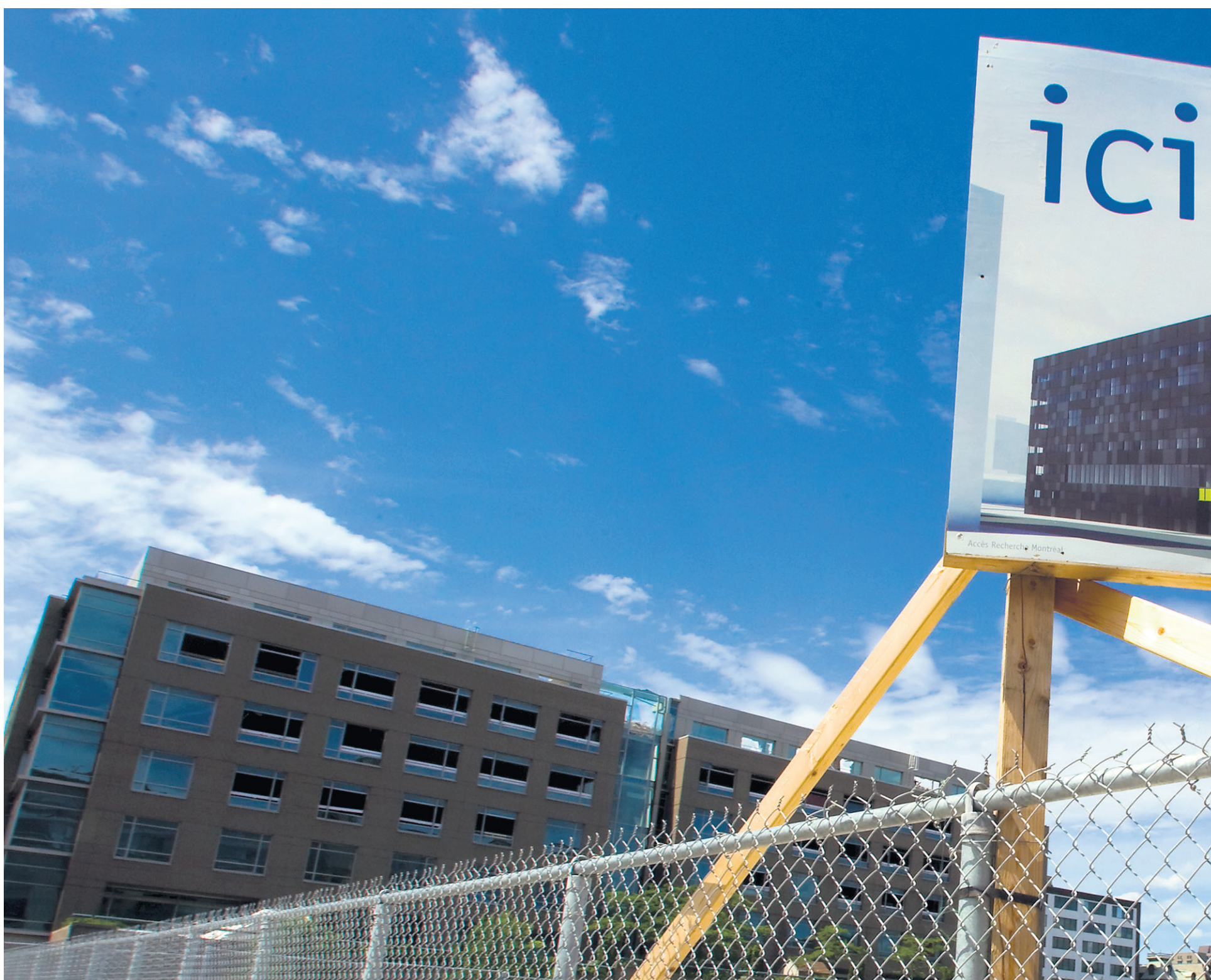
L'un des chantiers en vue de la construction du Centre hospitalier de l'Université de Montréal (CHUM) en bordure de l'ancien édifice de Vidéotron entre les rues Viger et Saint-Antoine, dans le
