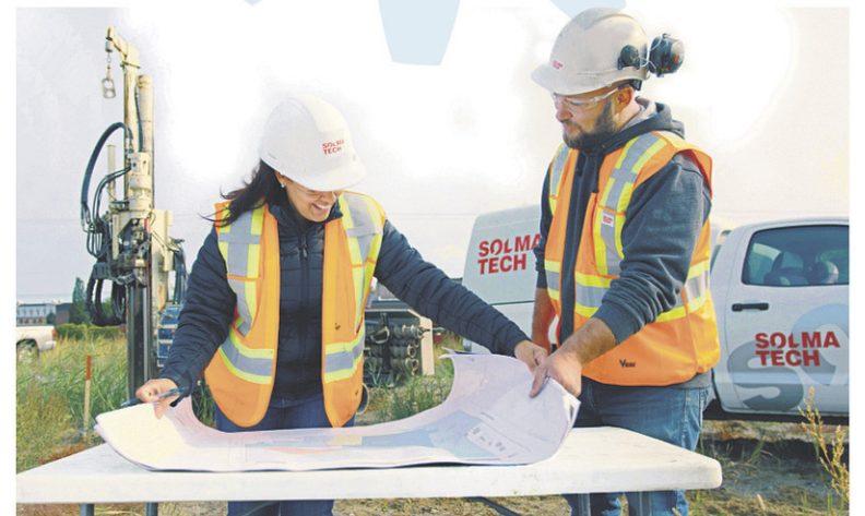
Contrôle de chantier – Photo: Solmatech
