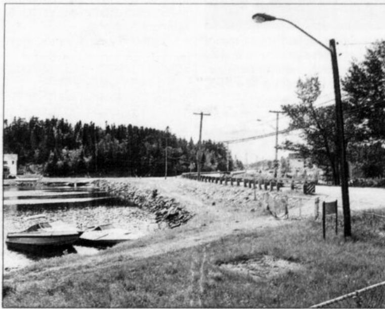
La digue sera rehaussée à cet endroit et un remblai sera installé dans le lac Kénogami.
