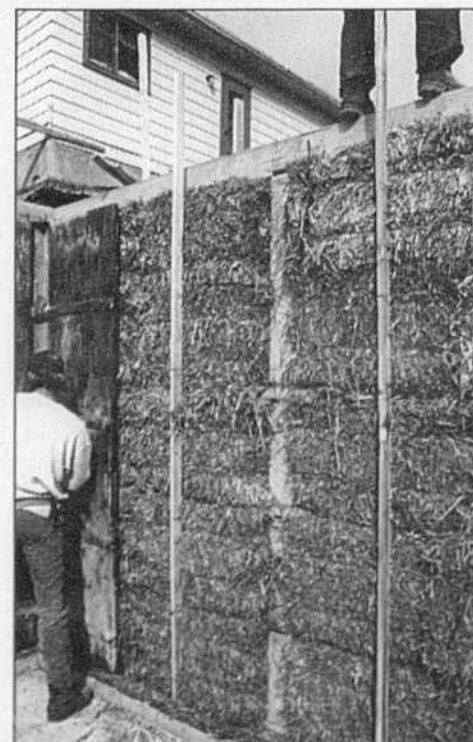
La paroi est prête à recevoir son coulage de béton, méthode de pointe signée ArchiBio (résidence Chaput-Camplone, Saint-Damien).
