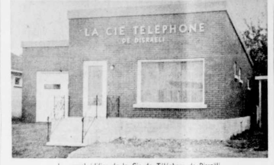
Le nouvel édifice de la Cie de Téléphone de Disraëli.
