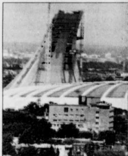
La tour en construction, destinée à faire partie de la silhouette de Montréal.
