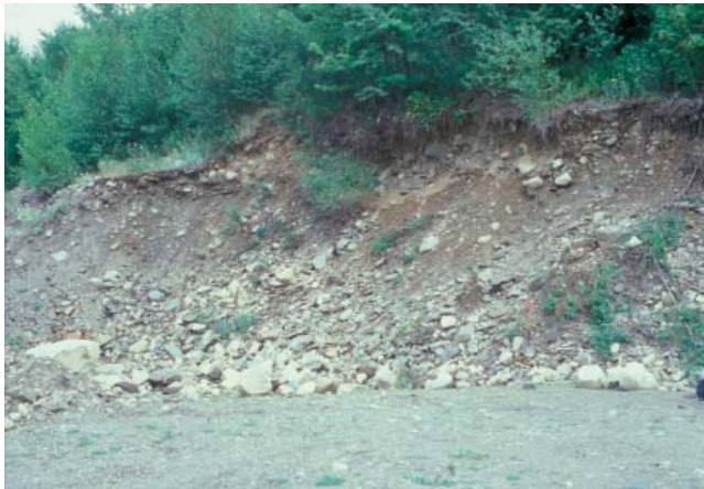
PHOTO 11 - Face de 4 à 5 m de hauteur effondrée et en partie couverte de végétation. Cette face est composée de gravier (40 à 50 %), de cailloux (15 à 25 %) et de quelques blocs soutenus par une matrice sableuse à sablo-silteuse sans structure (banc 51, gisement 24).
