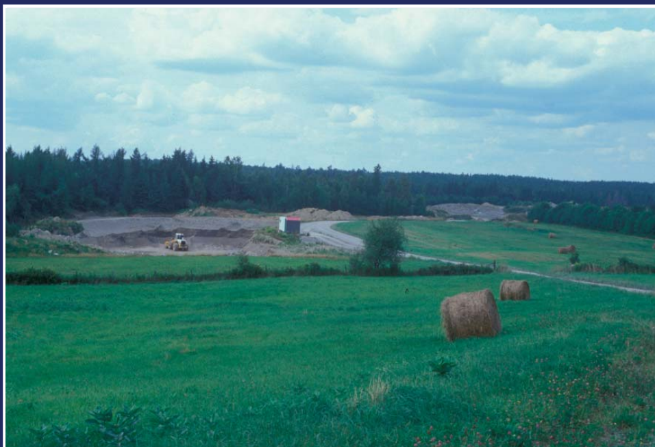
Delta glaciolacustre exploité comme source de sable et de gravier. Le dépôt se prolonge vers l'est et le nord (banc 10, gisement 2).
