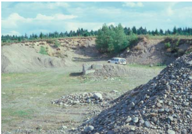
PHOTO 5 - Faces de 4 à 5 m de hauteur effondrées et en partie couvertes de végétation. Ces faces sont formées de gravier et de cailloux soutenus par une matrice sableuse à sablo-silteuse sans structure (banc 26, gisement 6).
