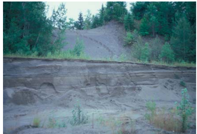
PHOTO 10 - Exploitation sur deux paliers. Le premier palier, en surface, expose une face effondrée de 4 à 8 m de hauteur formée de sable moyen à grossier avec 15 à 30 % de gravier. Le second palier, à la base, présente une coupe fraîche de 5 à 8 m de hauteur constituée de sable moyen à fin stratifié avec quelques passages silteux (banc 44, gisement 18).
