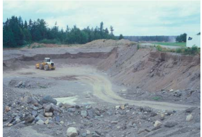
PHOTO 2 - Faces de 3 à 5 m de hauteur constituées de sable moyen à grossier stratifié avec quelques interlits de gravier. Présence de cailloux. On note la présence de stratifications horizontales et obliques typiques d'une sédimentation deltaïque (banc 10, gisement 2).
