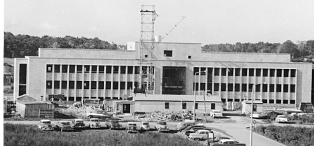
Construction du Centre de foresterie des Laurentides en 1957.
