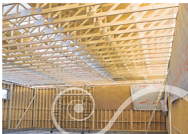
Le choix d'une ossature légère en bois pour le gymnase de l'École Vision dans l'arrondissement Sillery à Québec, a permis de réaliser des économies et de construire un bâtiment «vert».
