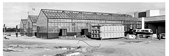
Construction des serres adjacentes au CFL.
