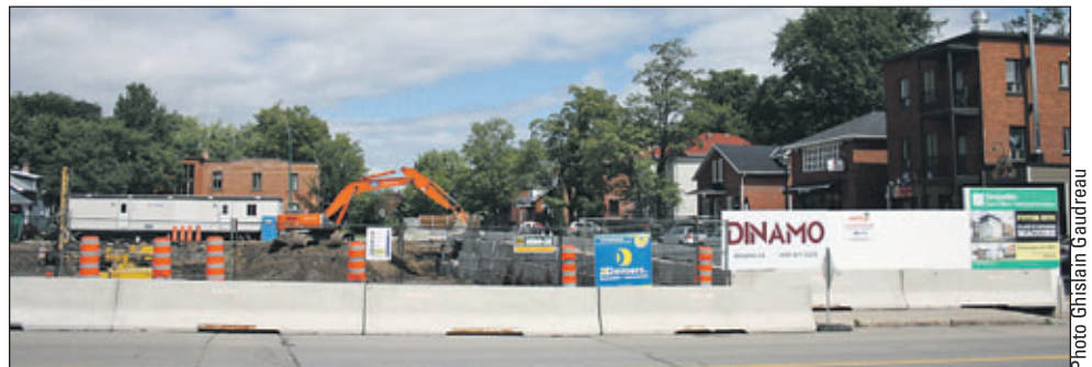
La construction du stationnement intérieur devrait débuter bientôt pour se poursuivre avec l'élévation de l'édifice. Rappelons que la fin des travaux est prévue pour le printemps 2012.
