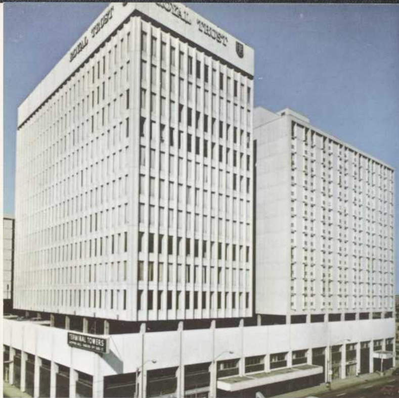
1. Panneaux préfabriqués en béton aux Terminal Towers, Hamilton, Ont.
