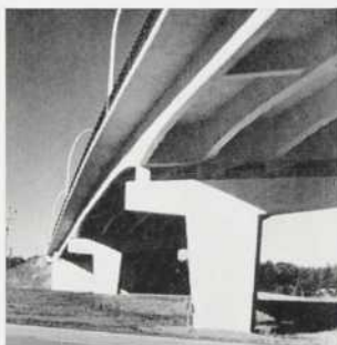
Ponts de l'autoroute Montréal-Laurentides
