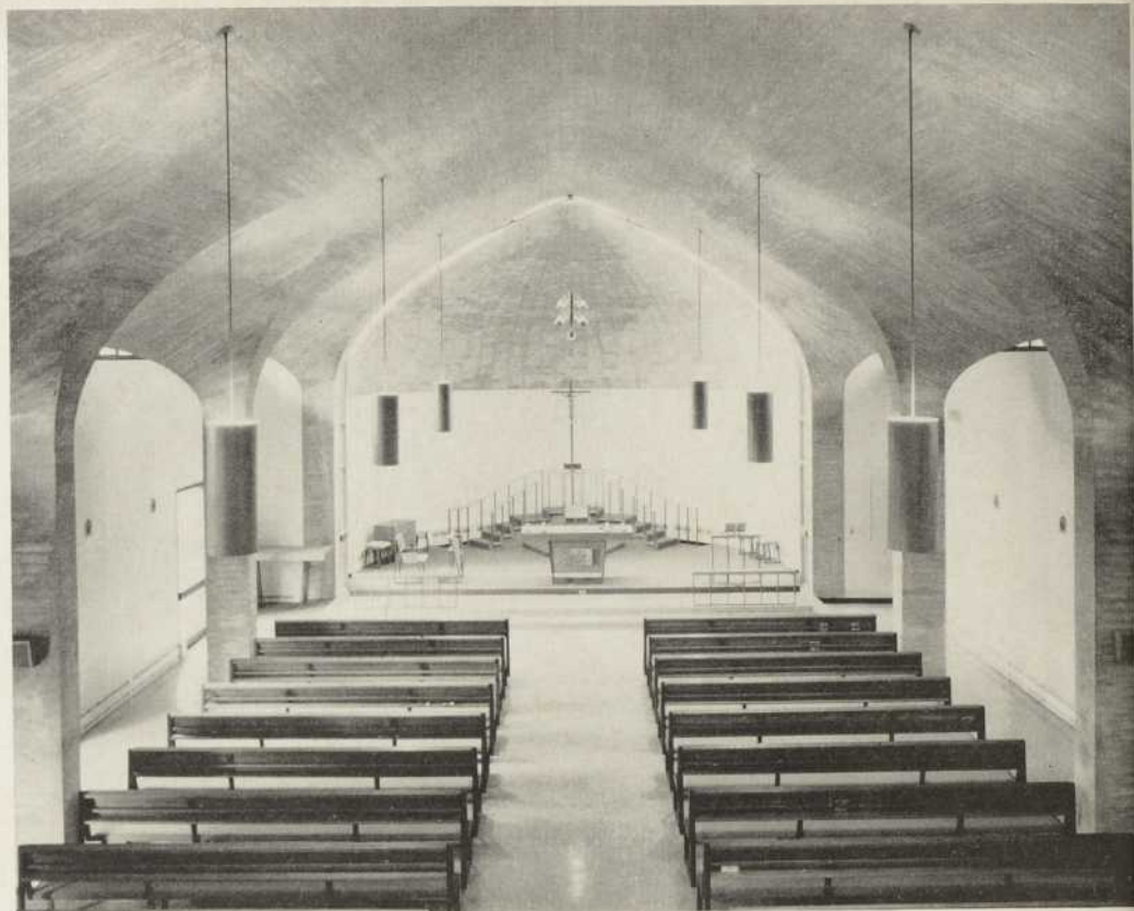
Vue intérieure de la chapelle. A noter le travail de béton de la voûte, nue de décoffrage, qui fut bro- sée au jet de sable.
