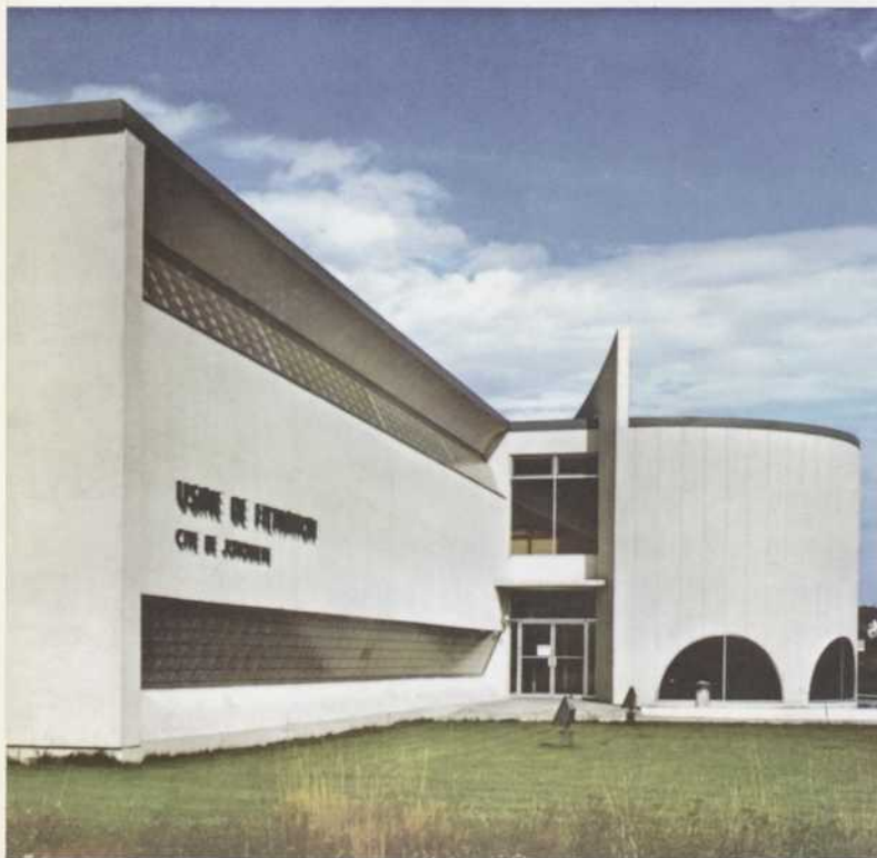
5. L'usine de filtration de Jonquières, Québec., édifice moulé en béton.
