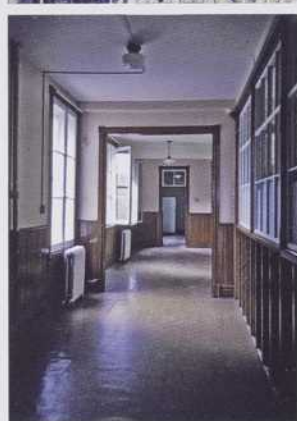
Le couvent du Bon-Pasteur, avant les travaux (photos Jean Côté, architecte).
