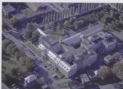
1. Québec. L'Hôpital général de Québec, établissement fondé en 1692 dans les murs du couvent des récollets établi en 1620 et reconstruit entre 1670 et 1682 (photo Pierre Lahoud).
