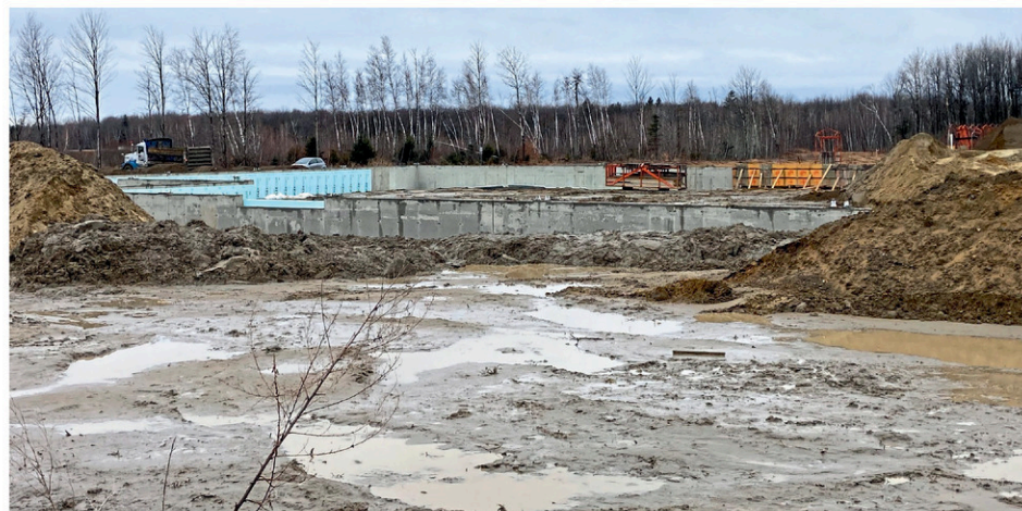
Du côté industriel, les travaux de construction de la nouvelle usine de Fondalco se sont aussi amorcés dans le parc industriel de la Ville de Plessisville.
