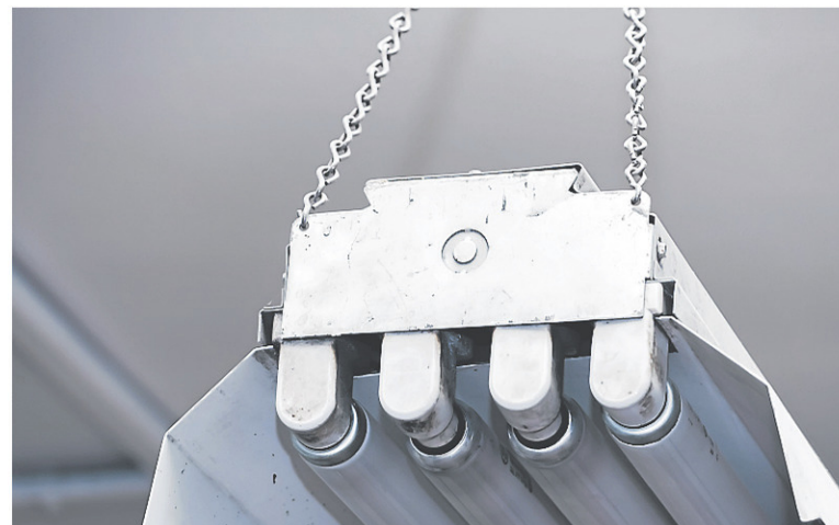
L'extrémité des tubes fluorescents devient noire vers la fin de leur vie utile.
