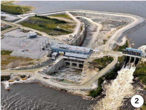
Centrale de la Sarcelle (en construction)
