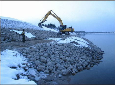
Pose du péré de protection sur le talus
