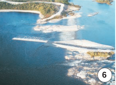
Seuil du PK 290
