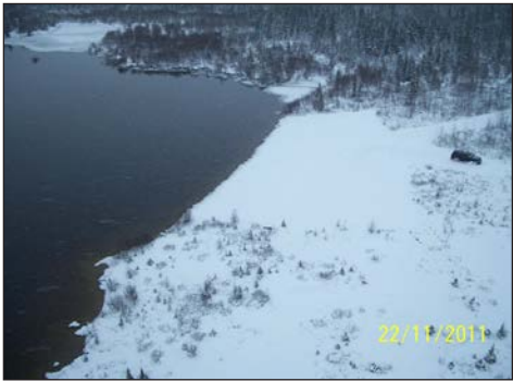
Rampe de mise à l'eau aménagée par l'entreprise Mookabi Construction qui a été désignée par le maître de trappage
