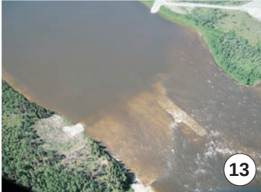
Tapis en enrochement du PK 20,4
