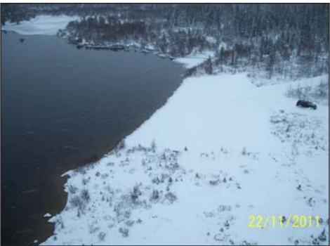
Rampe de mise à l’eau et plage d’échouage aménagées sur le terrain de trappage CH33
