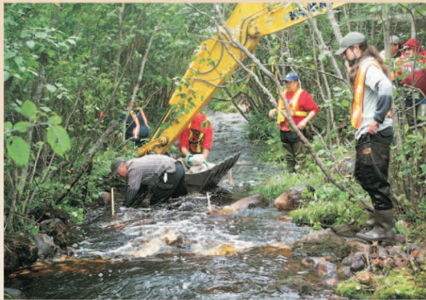
Aménagement d'une frayère à omble de fontaine
