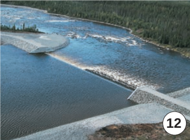
Seuil du PK 33
