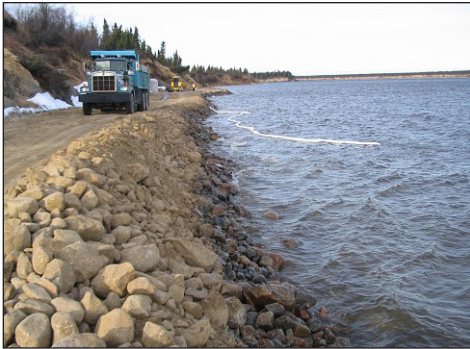
Tapis granulaire en construction
