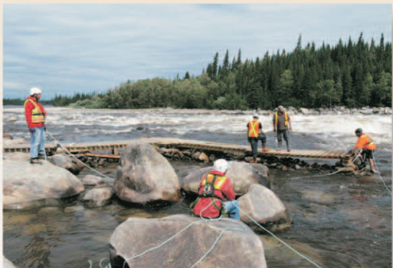
Travaux d'aménagement au site de Smokey Hill
