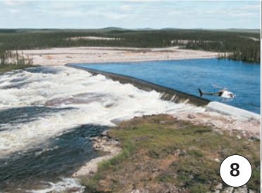
Seuil du PK 170
