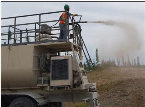
Équipement utilisé pour l’ensemencement hydraulique autour des étangs de chasse à l’oie
