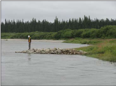
Épi intégré au tapis granulaire au PK 16
