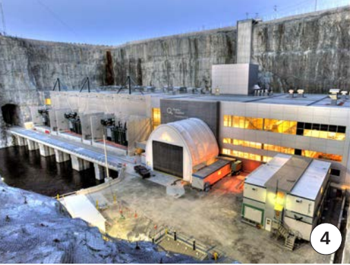
Centrale de l'Eastmain-1-A (en construction)
