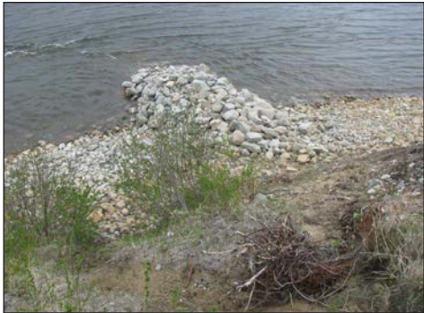
Épi intégré au tapis granulaire au PK 9
