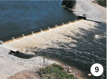
Seuil du PK 110,3
