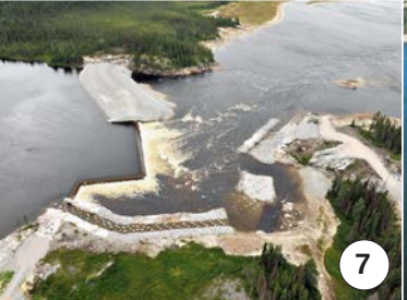
Seuil du PK 223
