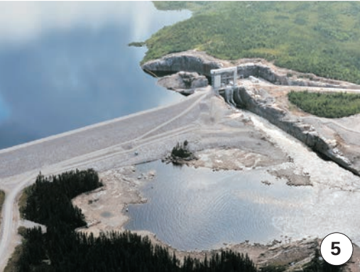
Barrage de la Rupert
