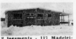
2 logements - 117 Madeleine, Chic.-Nord. 1) 3 chambres, salon, cuisine, salle à diner. 2) 3 chambres, salon, cuisine, salle à diner. 1 carpot, salle de couture.
