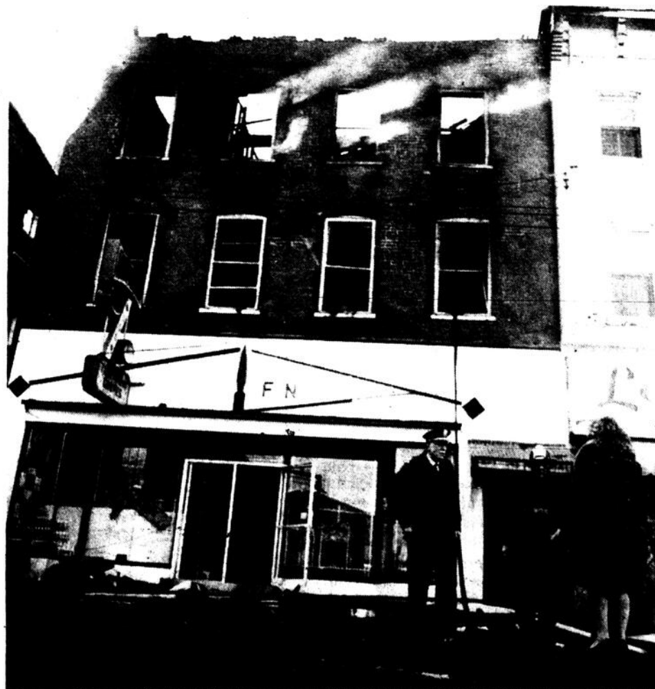
Voici l'état de l'édifice après que les sapeurs eurent maîtrisé les flammes.
