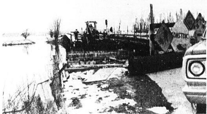
Et pendant ce temps, des ouvriers s'affairent à démolir l'autre moitié de ce pont qui enjambe l'un des bras du fleuve.
