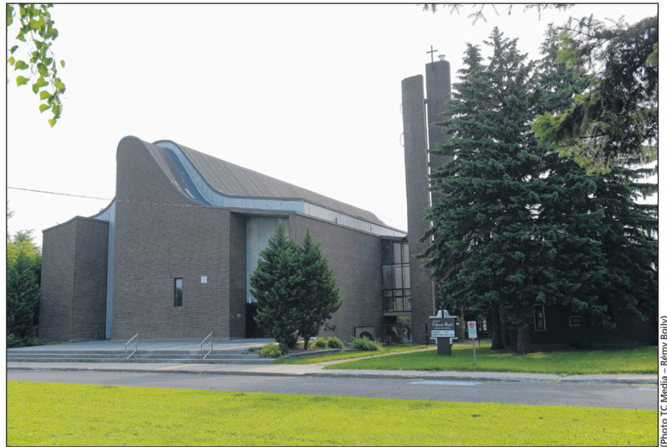
La fabrique est en pourparlers avec un promoteur pour la vente de l'église Saint-Gérard-Majella. Celle-ci serait démolie.
