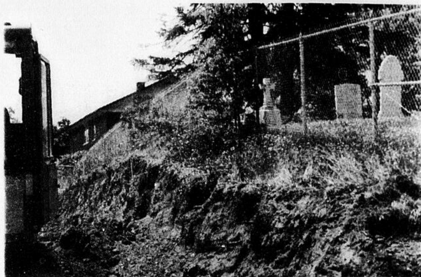
M. Gordon Pozer craint pour le cimetière, surtout depuis qu'on a creusé une tranchée pour y ériger un quai.
