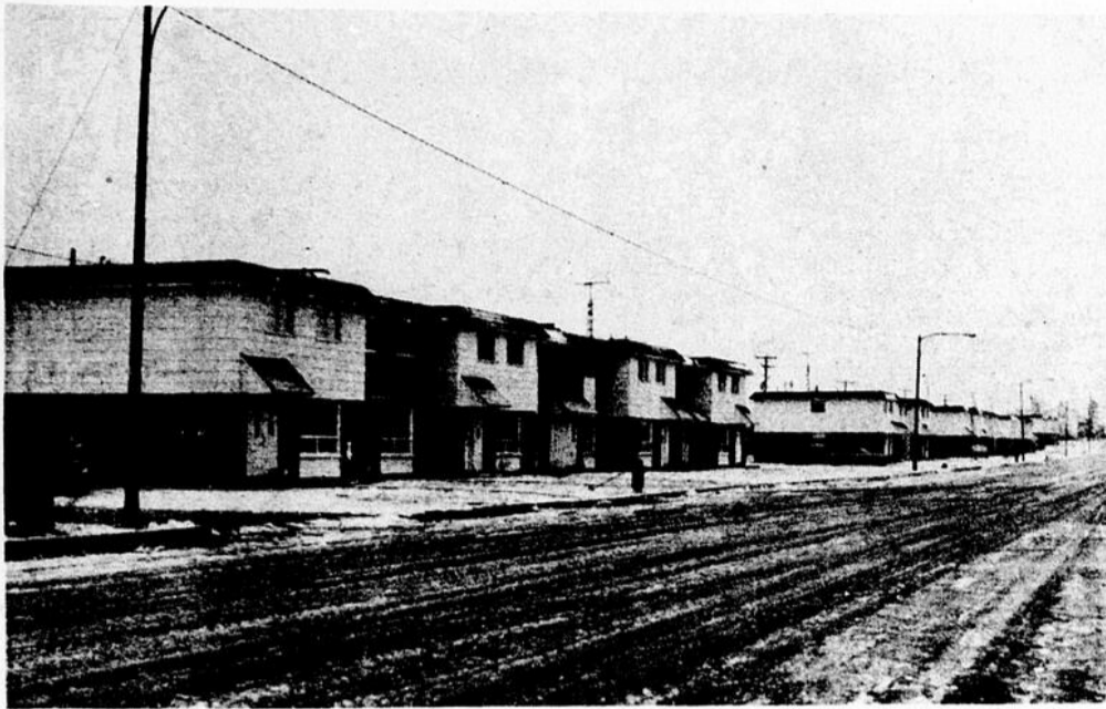
La rangée de logements municipaux de l'avenue Côté à Montmagny, construits depuis 1970.
