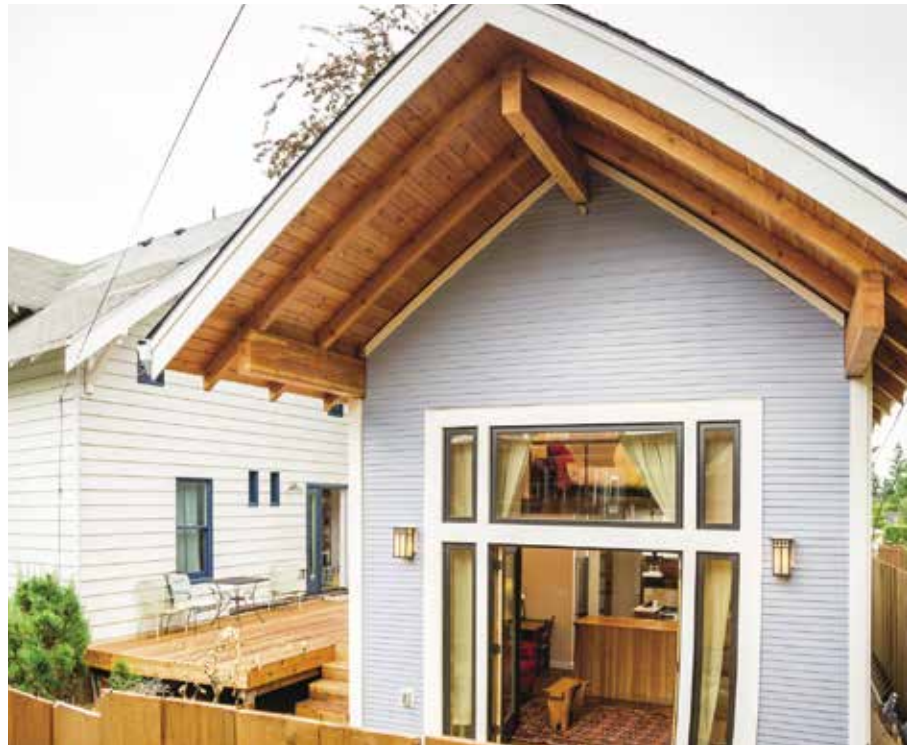
▲ Unité d'habitation accessoire à Portland (Oregon) Photo : BuildinganADU.com
