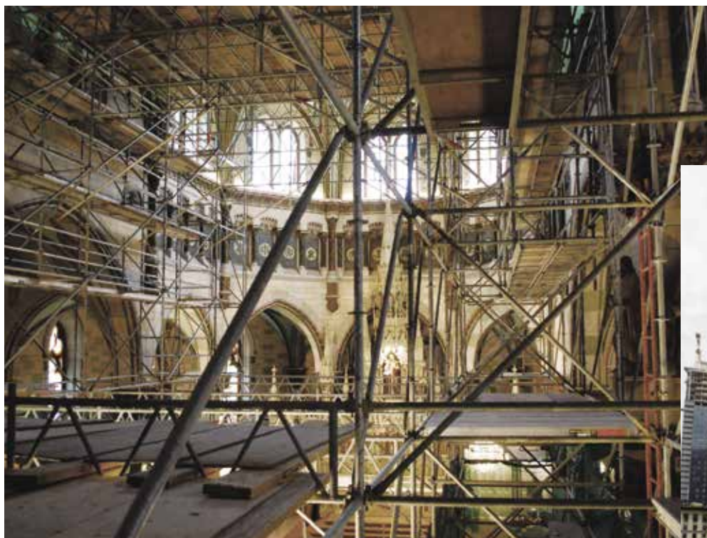
Restoration de la huitième maison mère de la Congrégation de Notre-Dame, Montréal, Nadeau Nadeau Blondin architectes Photo : Nadeau Nadeau Blondin architectes
