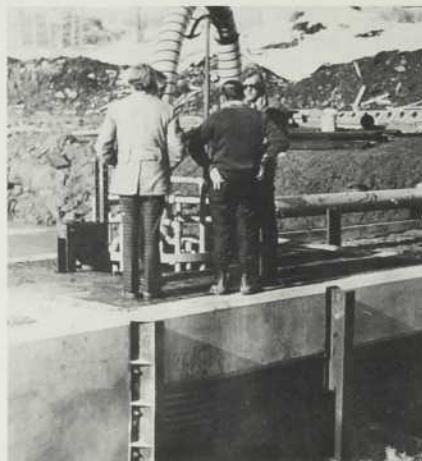
Les ingénieurs discutent de l'installation de réoxygénation.
