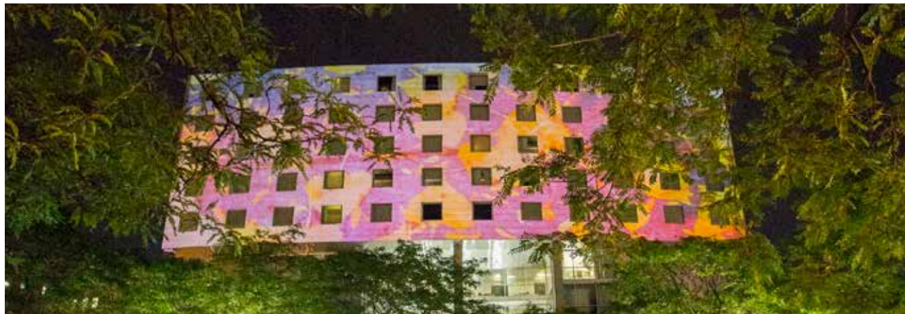
▲ Déravage , façade de l'Hôtel 01
