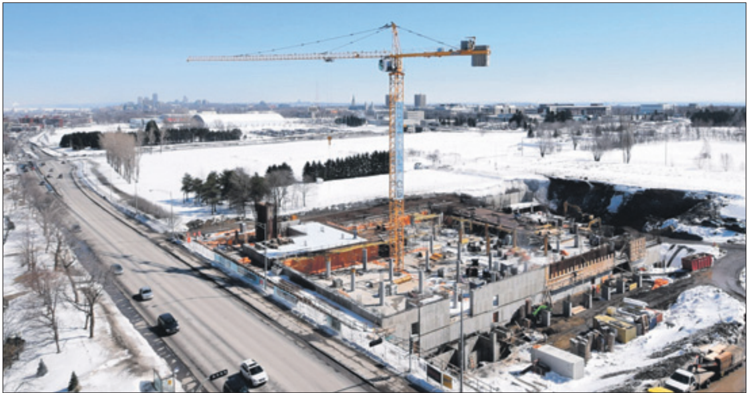
Vue en plongée du chantier du Quartier QB, dont les premières unités seront livrées en juillet 2016, avec le IGA directement sur le chemin des Quatre-Bourgeois.
