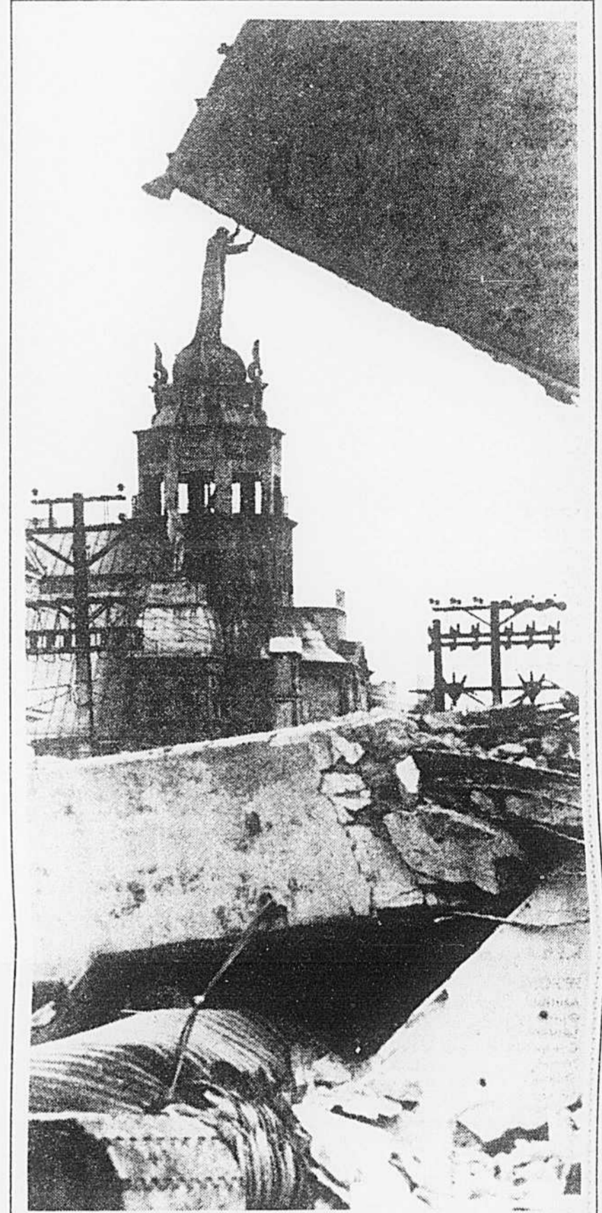
Un échec On ne saura jamais si Notre-Dame-de-Bonsecours y fut pour quelque chose mais la démolition du silo no 2 dans le Port de Montréal par la compagnie Beaver, samedi, s'est soldée par un échec. En effet, bien qu'on ait bourré la structure de l'édifice de 1,200 livres de TNT, la charge ne fut pas suffisante pour renverser le bâtiment. Le hangar à grain qu'on voulait détruire pour ouvrir la Place Jacques-Cartier à la vue du fleuve a simplement penché comme sa sœur de Pise.
