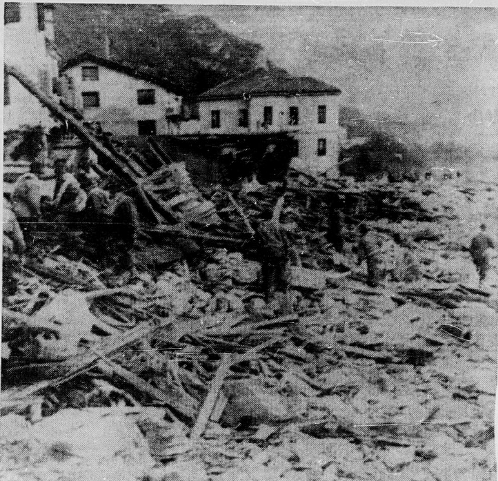
ON RECHERCHE LES VICTIMES — Des soldats fouillent les débris qui jonchent le village de Longarone, Italie, à la recherche des corps des personnes qui ont perdu la vie à la suite de l'effondrement d'un barrage dans les Alpes italiennes. On estime que près de 2.000 personnes ont péri par la noyade.
