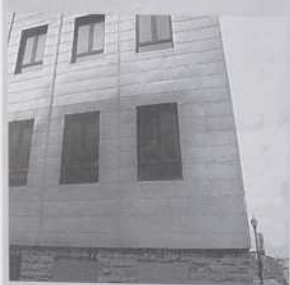
Saint-Roch retrouve le revêtement de tôle des façades latérales et arrière, caractéristique: les Lofts de la Fabrique.
