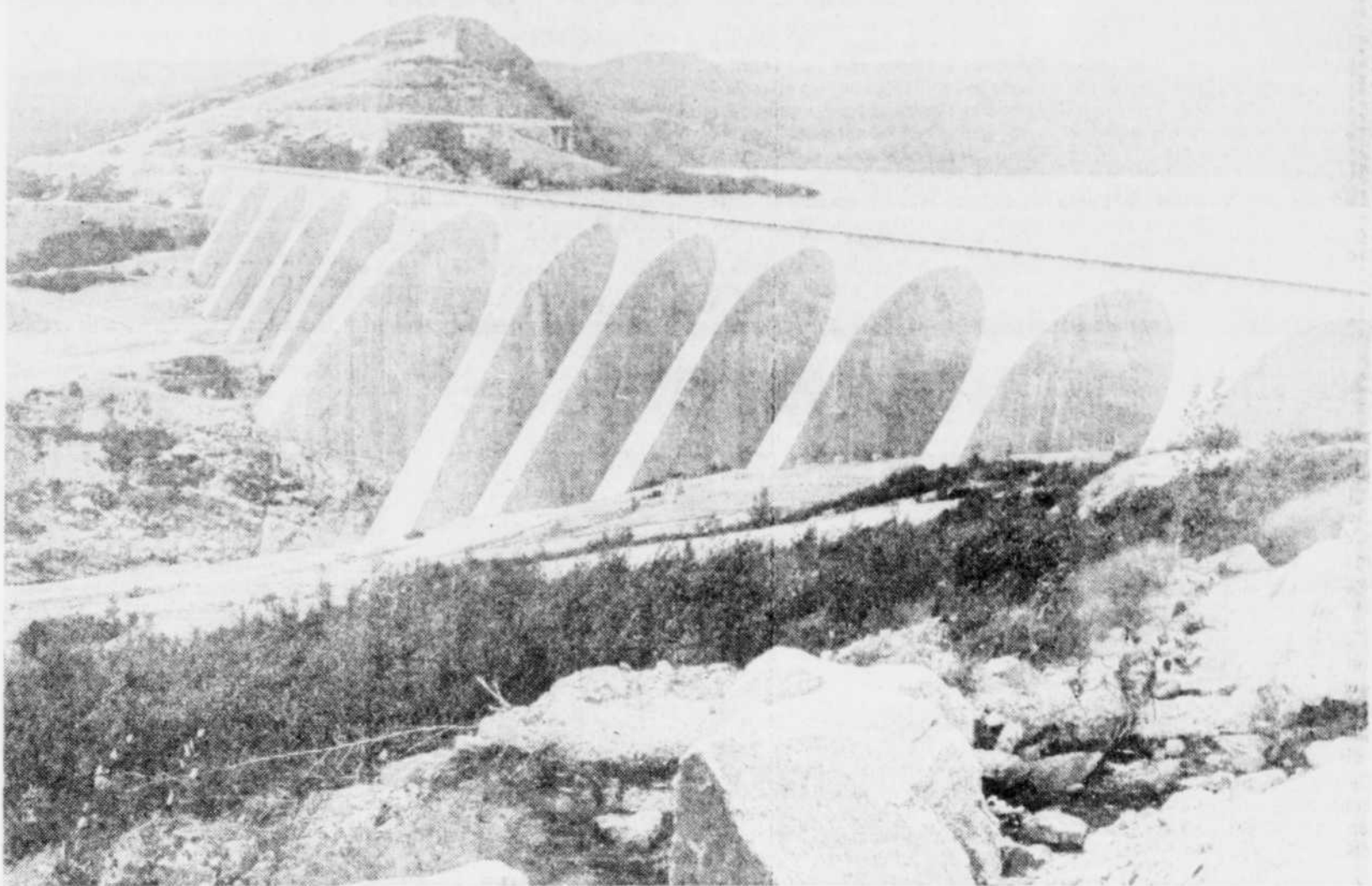
Il y aura des travaux de confortement au barrage Daniel-Johnson, mais vraisemblablement ce n'est pas pour cette année.
