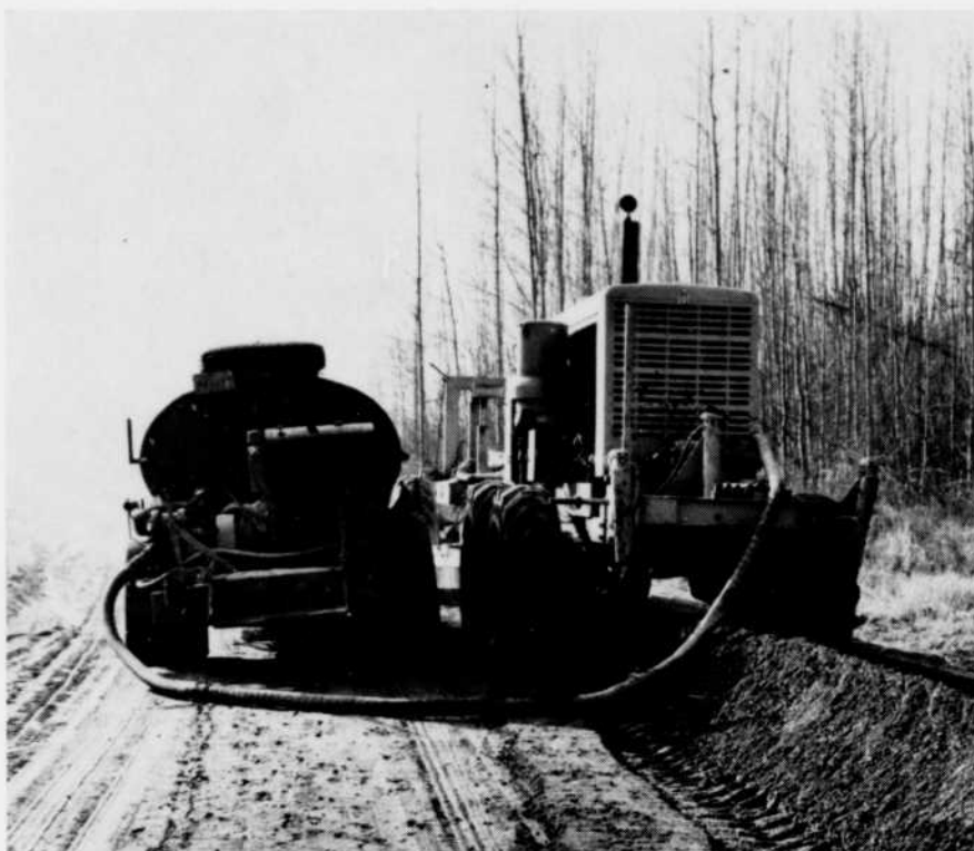
Cette vue de l'arrière-train du malaxeur et du camion citerne montre le mélange de sol-ciment déposé sous forme d'andain. On procède ensuite au nivellement et à la compaction du sol-ciment.
