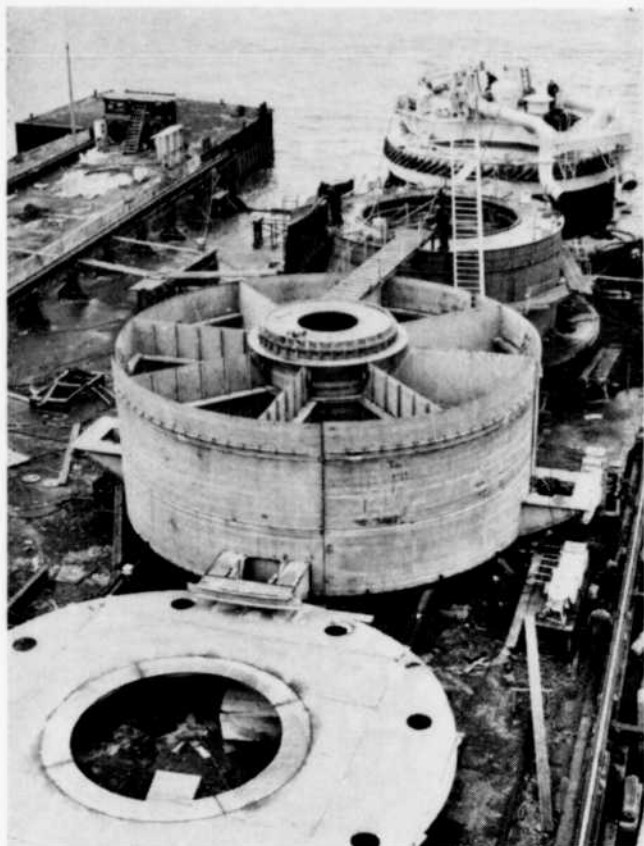
Vue des différentes phases de la construction
