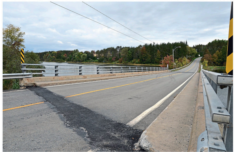
Le pont Hillcrest sera converti en passerelle cyclo-piétonnière l'an prochain.
