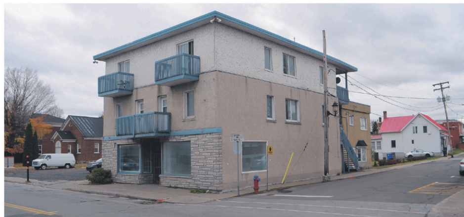
La Ville de Farnham est actuellement en appel d'offres pour la démolition de l'ancien immeuble de Guy Gendron situé à l'intersection des rues Principale est et Saint-Vincent.
