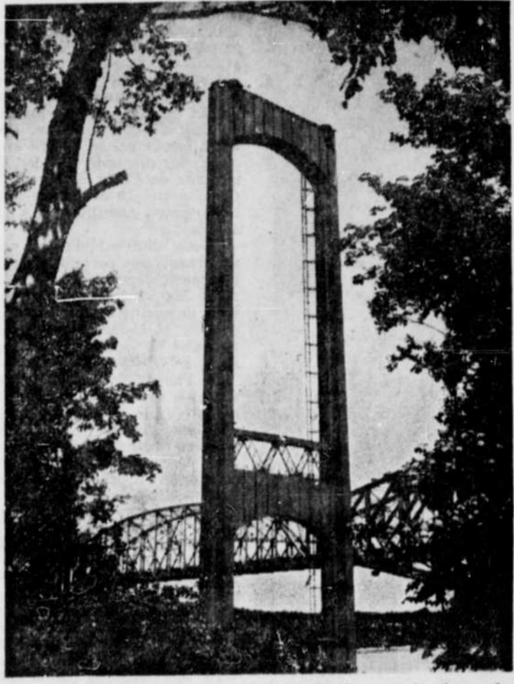
● LE PYLON du nouveau pont de Québec sur la rive sud du Saint-Laurent s'élève à une hauteur de 455 pieds.
