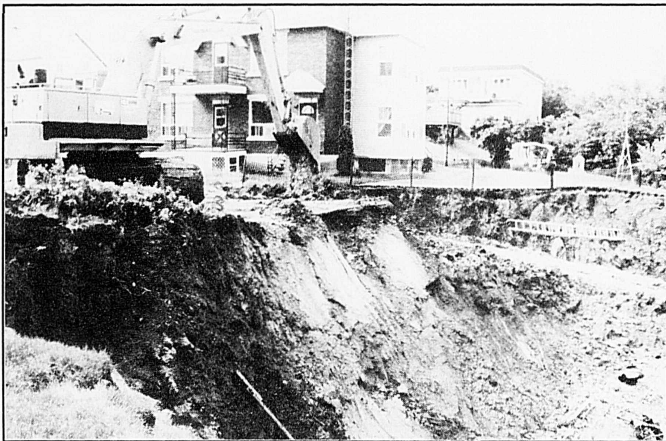
Dès lundi matin, des employés de Grandmont et fils s'affairaient à ajouter de la pierre afin de renforcer le sol, à l'endroit où a eu lieu le léger glissement de terrain. En arrière-plan, une des deux maisons riveraines qui ont dû être évacuées, samedi après-midi. (Photo: P.P.M.).
