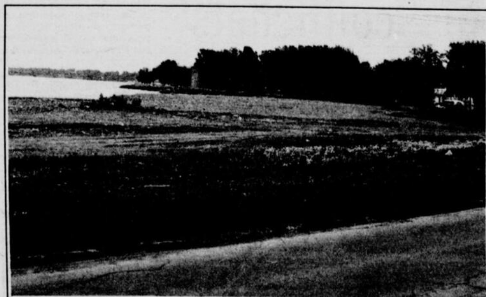
A la hauteur de la prison de Bordeaux, en bordure du boulevard Gouin, on a empiété sur la rivière des Prairies en vue d'aménager une future promenade pour les piétons le long de la rive.
