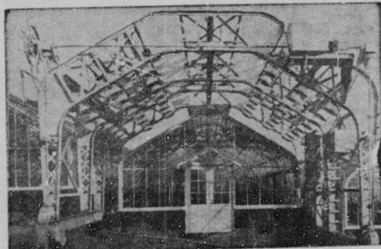
Plusieurs expériences ont été faites pour découvrir les effets de différentes quantités de lumière sur les plantes. Cette serre est dotée d'un circuit de 48 lampes de 1000 watts. Ce circuit sert à prolonger la durée d'une journée ordinaire.
