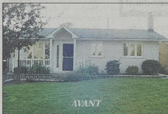
Rénovation extérieure d'une maison.
