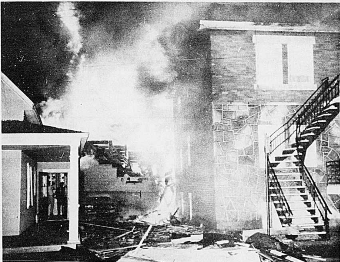
L'INCENDIE SE PROPAGE — Alors que la salle de réception s'écroulait sous la violence des explosions, le feu s'est propagé à l'immeuble que nous apercevons à droite et menace fortement la petite maison blanche, à gauche. Par la suite, l'incendie dévasta l'immeuble, dévorant le toit et s'engouffrant à l'intérieur. Cependant, on a pu circonscrire les flammes avant que la maison ne s'écroule. (Photo Gérard-H. Lachapelle)
