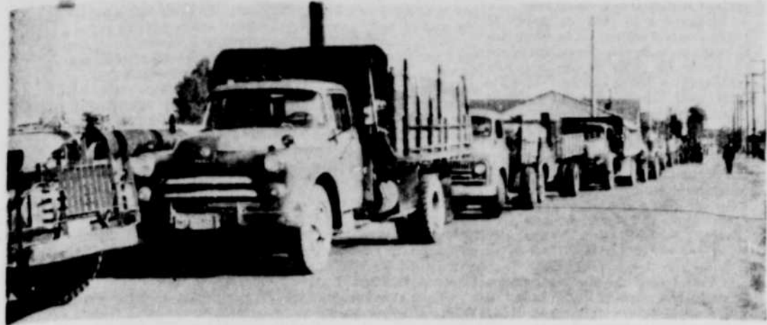
UNE QUINZAINE DE CAMIONS chargés de gravier et de pierre ont été immobilisés, hier avant-midi, à l'entrée des chantiers de construction du nouveau quai par la Foundation. Les camionneurs trifluviens avaient repris leur piquetage pour obtenir du travail et en sont venus à une entente avec le sous-entrepreneur après avoir adhéré à l'Union des camionneurs de la rive nord du Saint-Laurent affiliée à la C.T.C.C.
