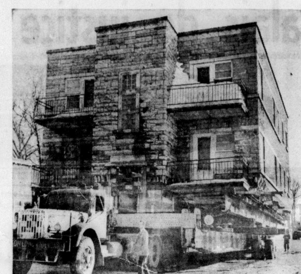
PLUS VITE QUE LES AUTOS — A l'heure de pointe, hier, près du pont Mercier, cette maison de deux étages "circulait" plus vite que les autos. On avait bloqué complètement la route, non toutefois sans avoir indiqué un petit détour pour accommoder les automobilistes. Il en résulta un embouteillage de première classe. L'heure de pointe passée, on immobilisa la maison pour la nuit, le déménagement devant reprendre aujourd'hui.
