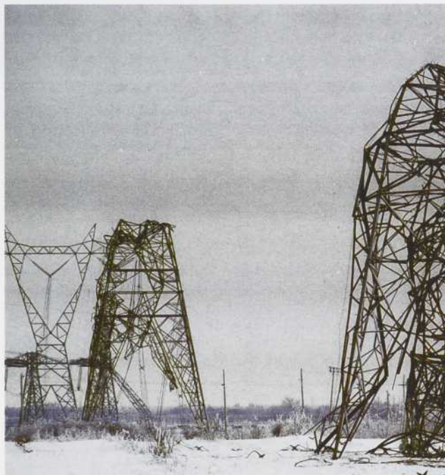
Lignes de transport d'Hydro-Québec détruites par la tempête de verglas en 1998.
