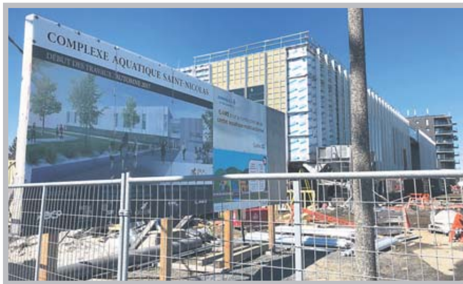
► Le complexe aquatique de Saint-Nicolas est sorti de terre au cours des derniers mois.
